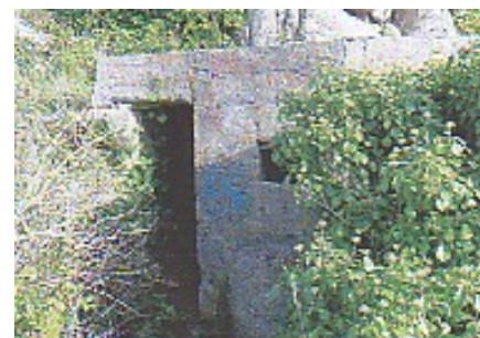
vestiges de blockhaus allemand construit en appui sur le rocher.
